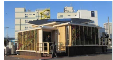
CLTを用いて2週間で建設。展示後は、慶應義塾大学へ移設。
