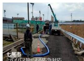
図 上下水道一体となった応急復旧対応
