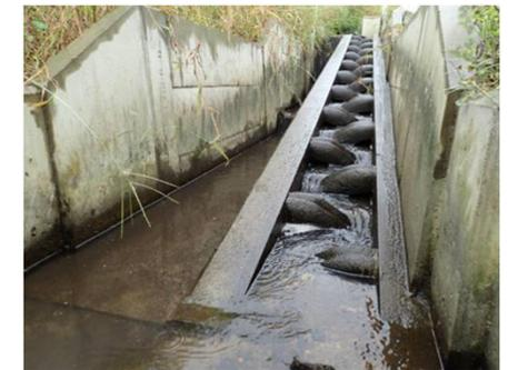
図 農業農村整備事業で設置した魚道
